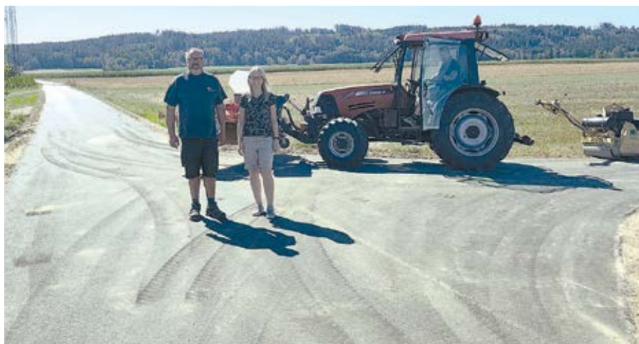
Ortsvorsteher Gerhard Weißenböck und Amtsleiterin Adele Strondl überzeugten sich vor Ort vom Baufortschritt und besichtigten die letzten Arbeiten am Hintausweg.
