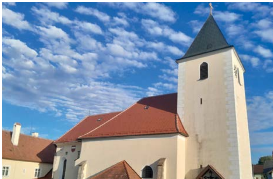
Die neu eingedeckte Pfarrkirche Höhenberg.
