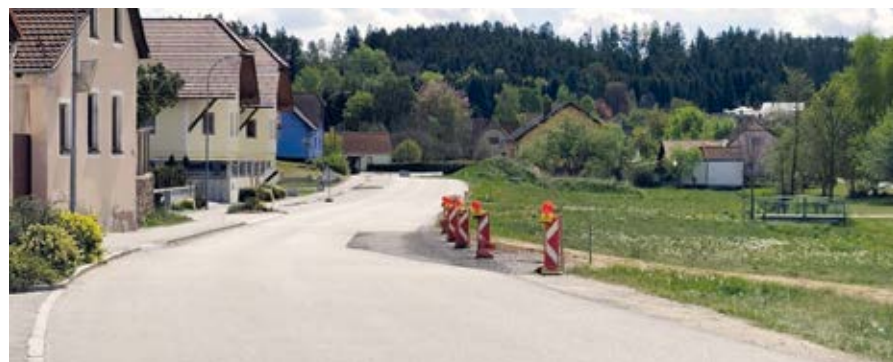
Die ehemalige Engstelle auf der Hörmannser Straße im Mai 2026.
