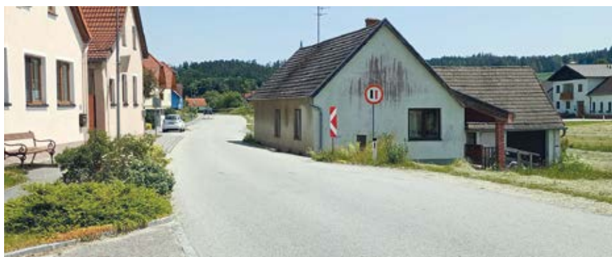
Das Haus Hörmannser Straße 42 sorgte jahrelang für eine Verengung der L8228.
