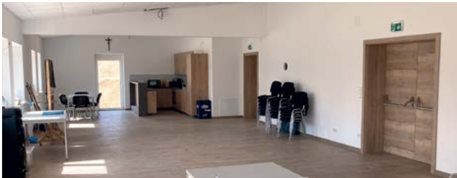
Der Sitzungsraum mit Küche ist schon fast fertig.
