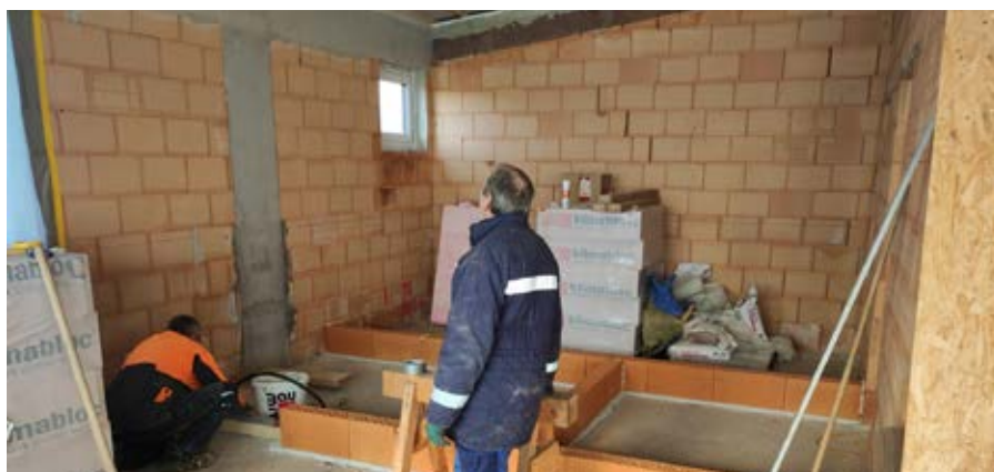
Das Gebäude nimmt Gestalt an - die Zwischenwände wurden gemauert.
