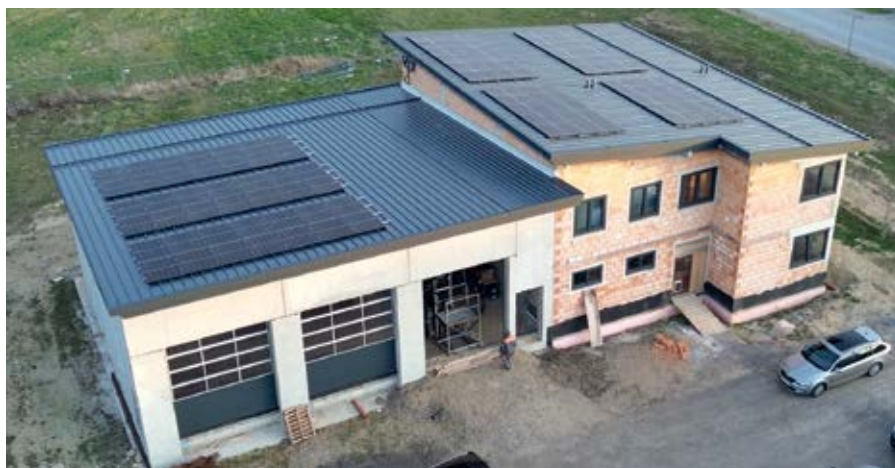
Das Feuerwehrhaus in Eichberg macht Fortschritte!
