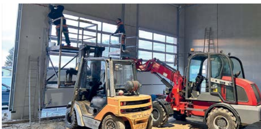
Die Tore wurden von den Feuerwehrmännern selbst montiert.
