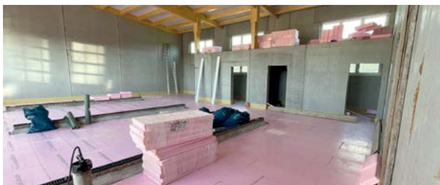
Die Dämmung am Boden der Fahrzeughalle ist verlegt.
