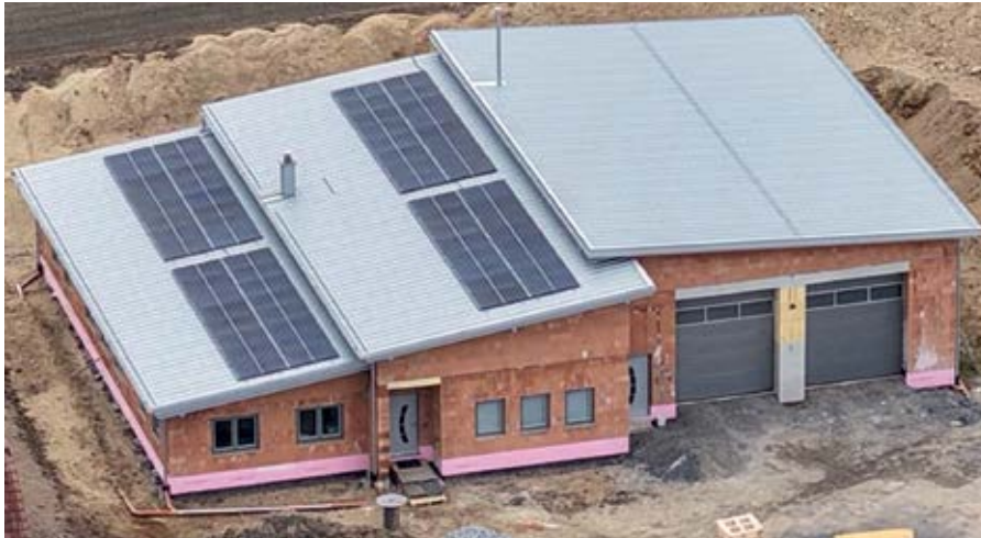
Das Feuerwehrhaus in Unterlembach ist im Bau schon weit vorangeschritten und verfügt mittlerweile auch über eine Photovoltaikanlage, damit die selbstständige Versorgung sicher gestellt ist.
