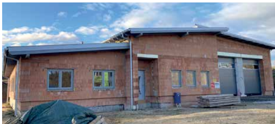
Der Bau des FF-Hauses in Unterlembach schreitet voran.
