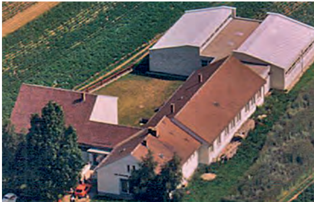
Das Anfang der 1960er-Jahre erbaute Schulhaus am heutigen Standort mit der Leiterwohnung links im Bild.
